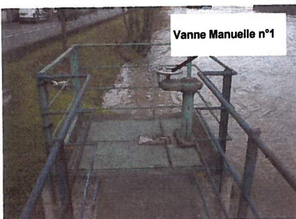
Localisation Vanne Manuelle n°1
